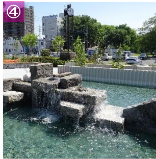
④ 駅前通りとシンボルロードをつなぐ結節点として、水と緑と花が調和した、上質な空間が広がっている ・池では水生昆虫（トンボ）、水鳥などの生物が来訪するなど、生物多様性に富み、広場の景観に彩りを与えている ・各種グリーンインフラが整備され、みどりに親しみながら四季の移ろいを感じることができる
